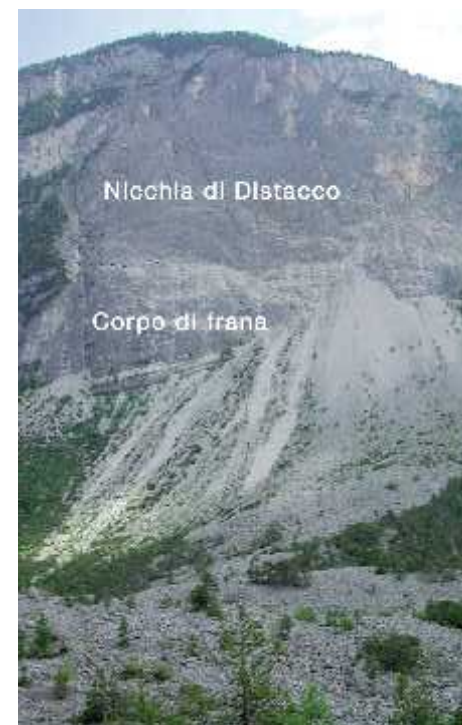
Fig. 8.40 - La grande nicchia di distacco della Frana delle Glare (foto P. Ferretti)
