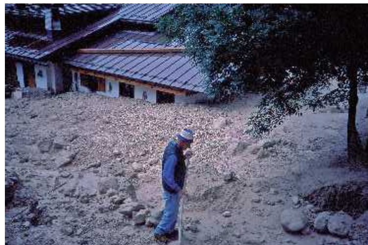
Fig. 5.8 - Effetto del "debris flow", che il 7 agosto 1996 ha invaso l'abitato di Borca di Cadore
