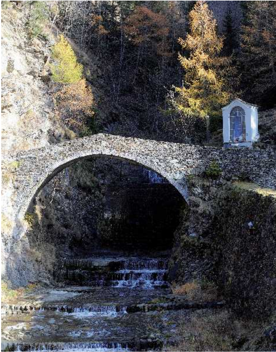
Figura 9.6 - L'antico ponte in pietra sul Torrente Rabbiosa, a monte di Campodolcino, punto di partenza del percorso all'interno del Monumento Naturale della "Caurga". Foto Gianpiero Mazzoni
