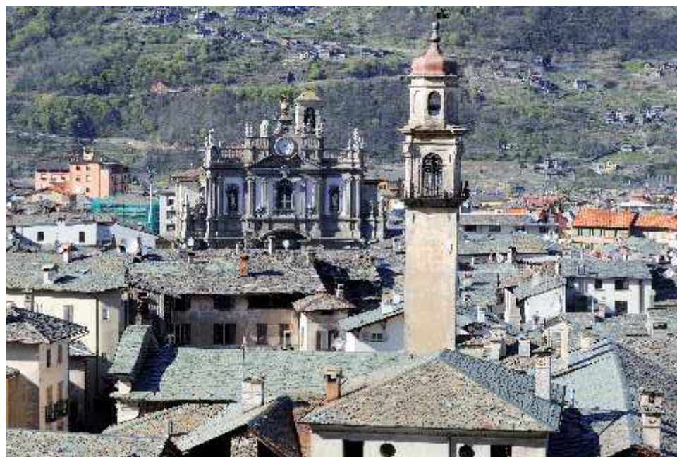
Fig. 12.8 - Panorama di Morbegno con i tipici tetti in piode
